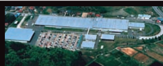
白河工場全景
